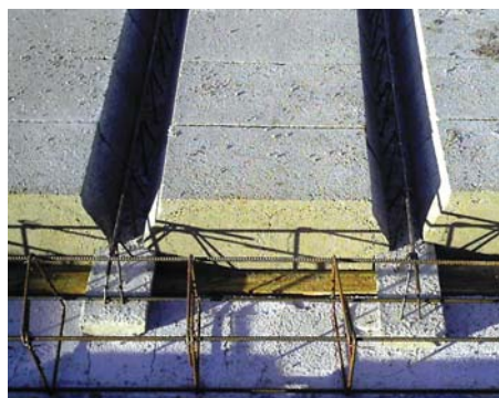
21. Koszorú melletti lezáró béléstestek
