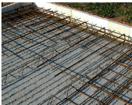
25. Koszorú kialakítása a födémşzelen
