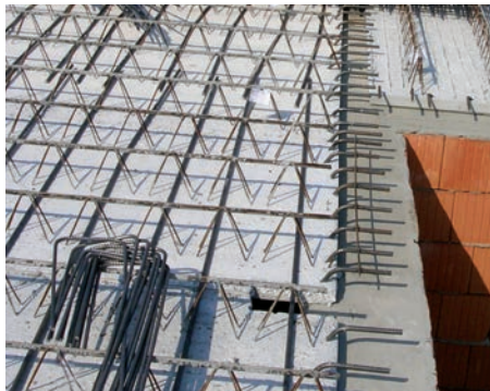
23. Két irányban teherhordó lemez keresztirányú vasalása Leier mesterpanelen (LMP)
