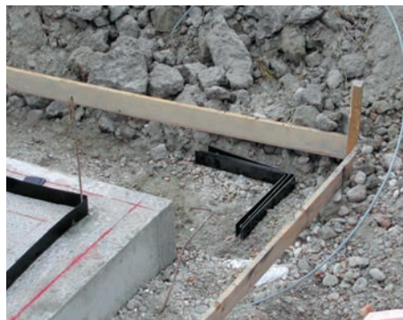
36. Falsarokhoz készített acélpántok a sarkok biztosításához
