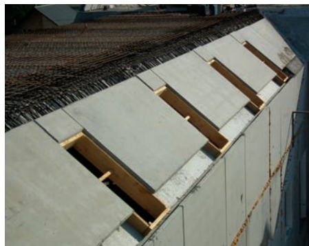
10. Leier kéregfal (LKF) alkalmazása koporsófödémként
