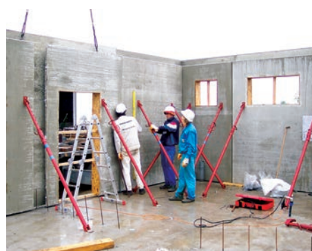
40. Leier kéregfal (LKF) pontos beállítása, ellenőrzése
