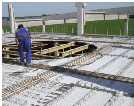
9. Födémáttörés mentén elhelyezett pótvasalás
