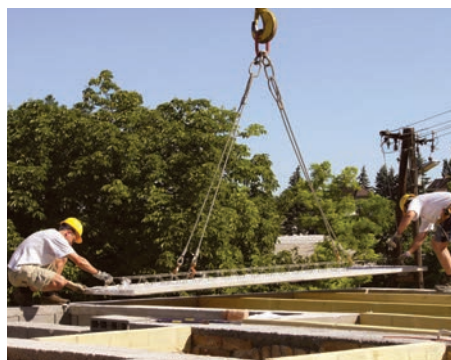
21. Leier mesterpanel (LMP) végleges elhelyezése
