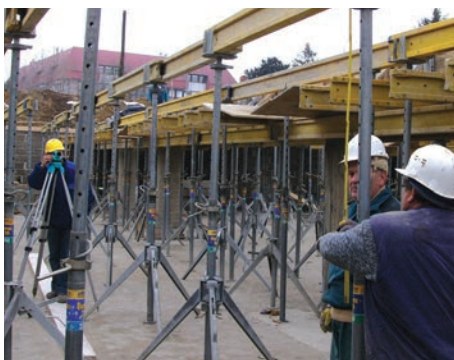
17. Alátámasztó állvány pontos beállítása, ellenőrzése
