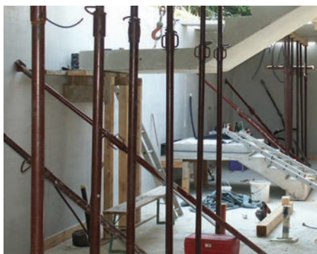
6. Külön elemekből álló Leier lépcső alátámasztása
