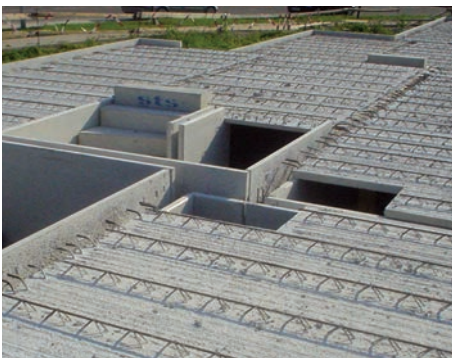
8. Födémáttörés tervezett helyeken
