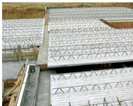
7. Falegyenre fektetett Leier mesterpanel (LMP)
