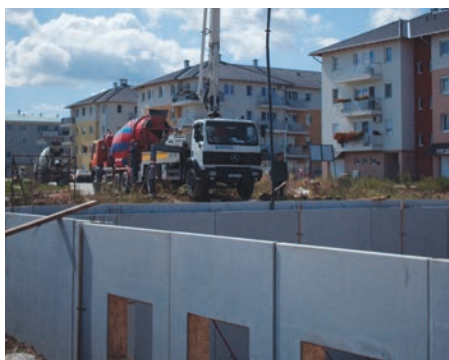
44. Leier kéregfal (LKF) kibetonozása
