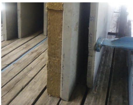
3. Leier kéregfal külső oldali hőszigeteléssel
