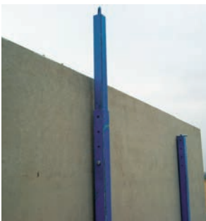
22. Állítható magasságú támasztóoszlop
