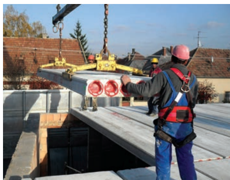
12. Födempanel óvatos beemelése
