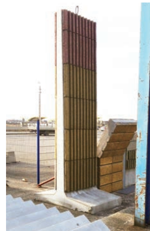
7. Durisol borítású mobil elválasztó falelem
