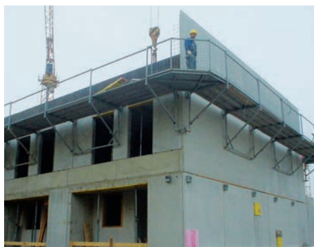
43. Munkaállvány betonozáshoz
