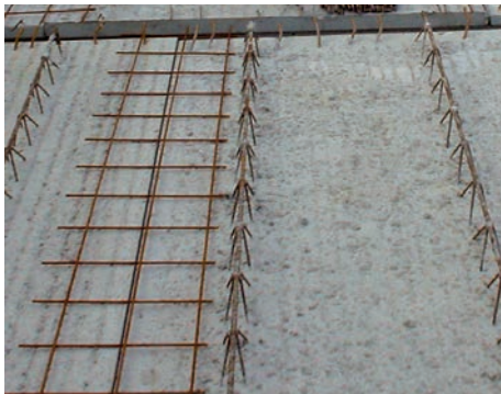
22. Elosztóvasalás Leier mesterpanelek (LMP) között
