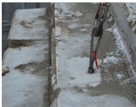
7. Előre elhelyezett függesztőelemek (dűbelek)
