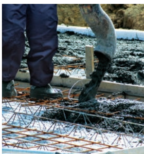
28. Betonozás betonpumpával
