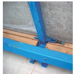
25. Támasztóoszlop rögzítése
