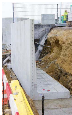
4. Szerelőbetonra emelt, beállított Leier támfal
