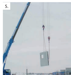
32. Leier kéregfal (LKF) levegőben történő forgatása
