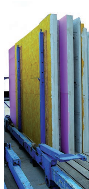
11. Leier kéregfal külső oldali hőszigeteléssel
