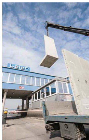
3. Támfal emelése szállítójárműről
