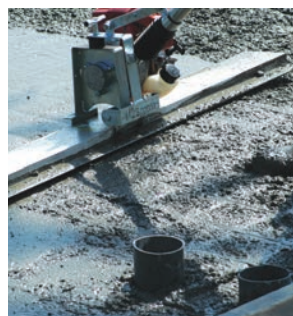
30. Helyszíni felbeton tömörítése, simítása
