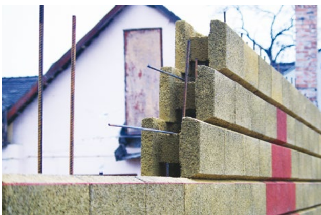
1.23 ábra Vasalat függőleges beépítése
