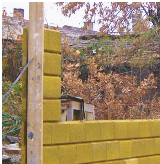
1.25 ábra A fal lezárása
