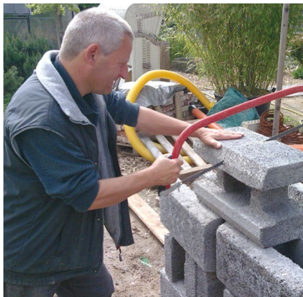
1.19 ábra Kézi fűrészsel végezhető gyors méretre vágás
