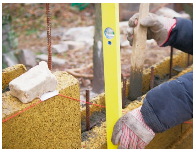
1.26 ábra Betonozás, tömörítés
