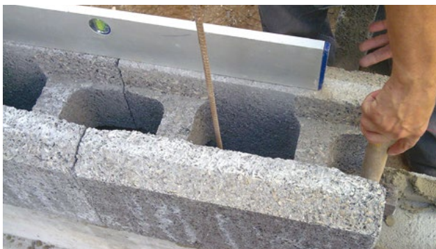
1.16 ábra Blokkelem beépítése
