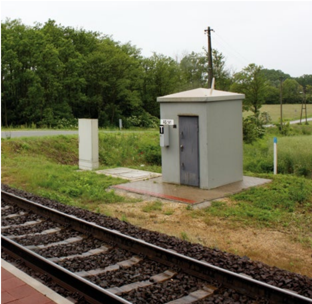
4.1 ábra Sorompó kapcsolóház
