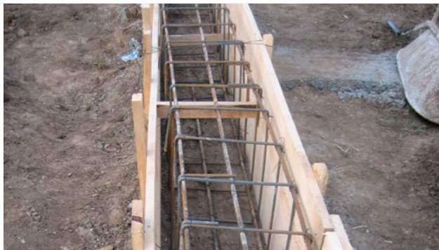
1.14 ábra Sávalap készítése
