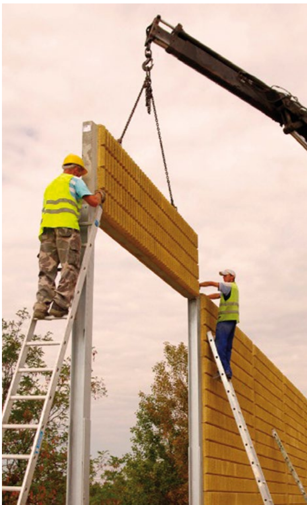
1.2 ábra A Leier zajárnyékoló falpanelek beépítése
