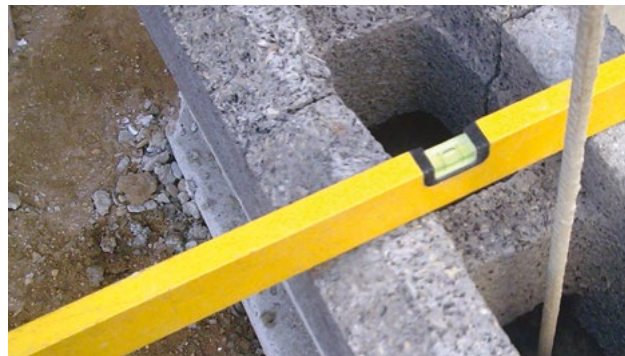
1.15 ábra Blokkelem beépítése
