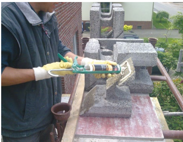
1.18 ábra Sarokelem ragasztása Leier FIX univerzális építési ragasztóhab használatával
