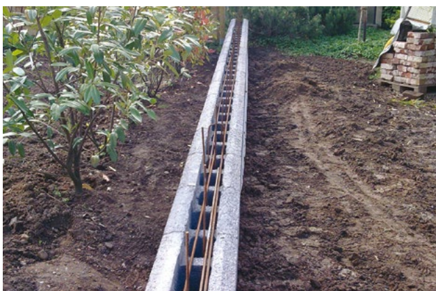
1.22 ábra Hosszvasak elhelyezése
