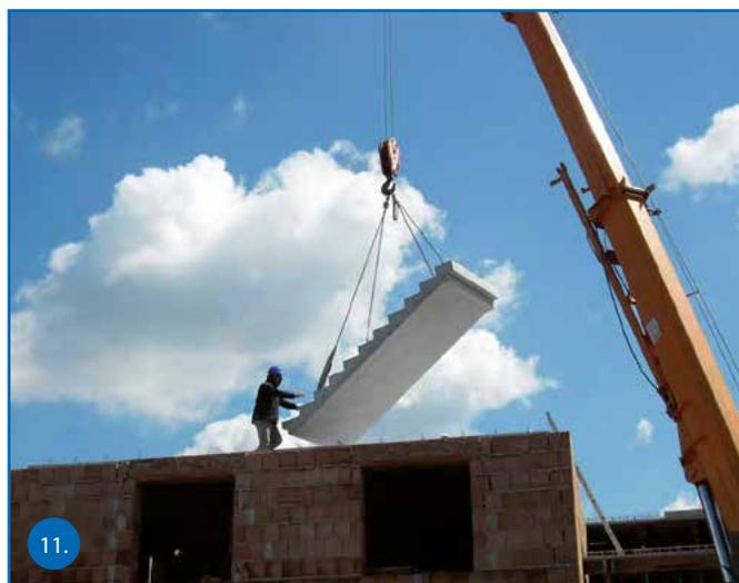
Beton-Fertigteiltreppe am Montagekran
