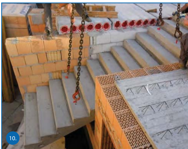
Lépcsőkar beépítési helyzetben felfüggesztve
