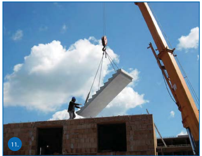
Méretre gyártott betonlépcső beemelése
