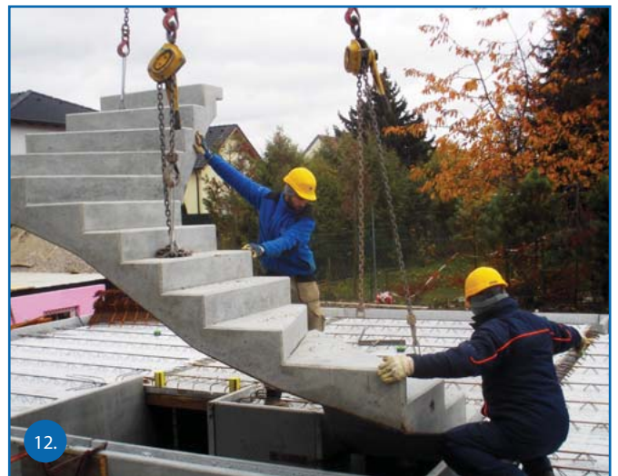
Egy lépcső beillesztése beépítési helyzetben
