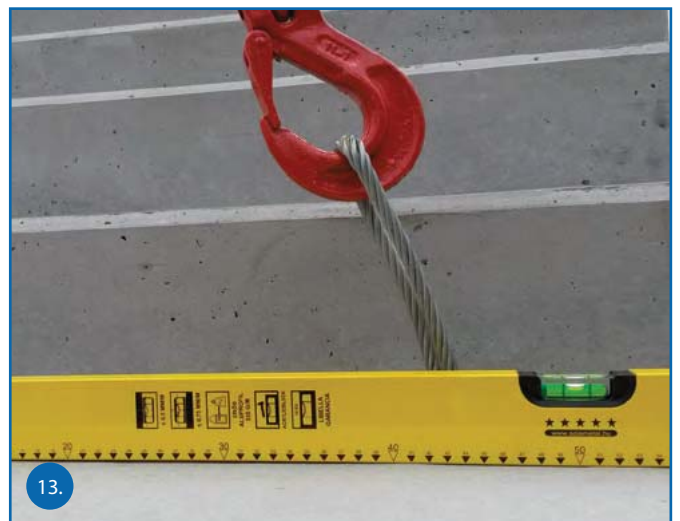
A lépcsőfokok a haladási irányra merőlegesen legyenek vízszintben.
