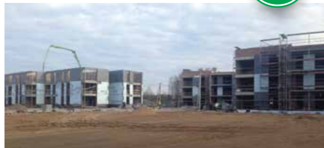
A három szintes „Giluzio Rivjera” lakópark Vilniusban. Az A-B-C-D-E lakóházak 2019-2020 között épültek. Az építkezéshez felhasznált DURISOL elemek: DMI 20/13, DMI 25/18, DSs 30/15 L
