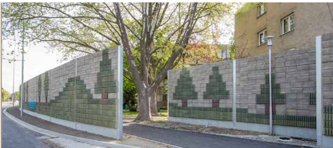
Kitűnő léghanggátlás érhető el a Leier Durisol zajárnyékoló falrendszerrel – győri példa
