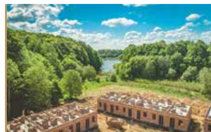
Litvánia/Vilnius lakóházegyüttes TOWNHOUSE stílusban, ami kedvelt építési mód az elővárosokban és a természeti környezetben. Kéteemeletes sorházak, gyakran tetőteraszos megoldással. Szállított anyag: 3500 négyzetméter DMI 25/18 falazóelem
