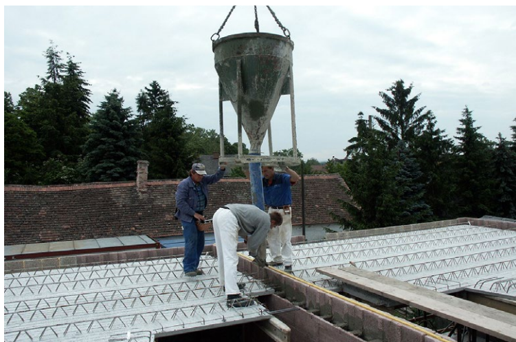
2.11. ábra Lakáselválasztó falak betonozása teljes magasságban, a kéreg- panelek egyben a munkaszintet is biztosítják
