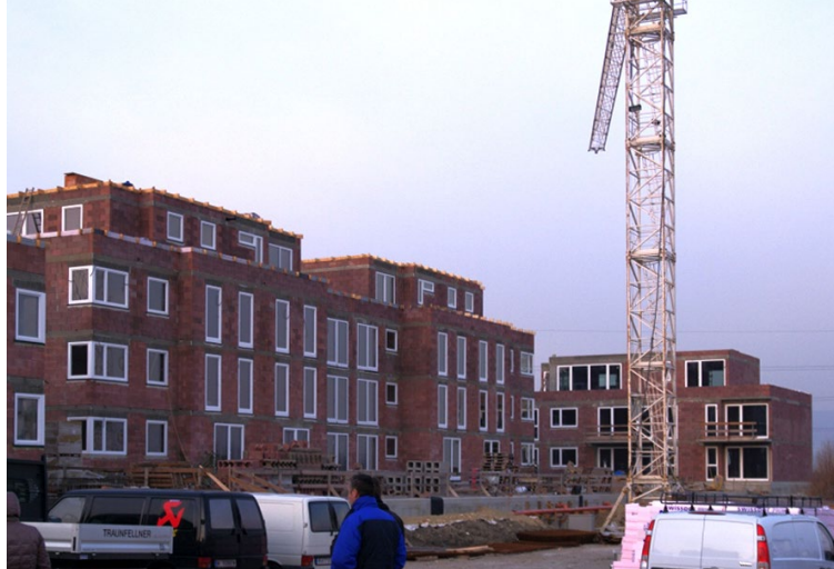
5.7. ábra Egy ausztriai Durisol szerkezettel épülő társasház projekt, három négyzetes épülettel, szerkezet-építés közben
