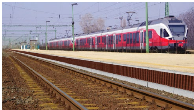
1.9. ábra Durisol vasúti peron- elem alkalmazása
