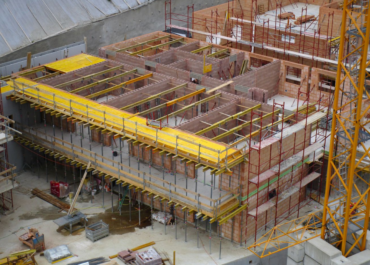
5.10. ábra Lakáselválasztó falak építése kéregfalakkal Sankt Pöltenben
