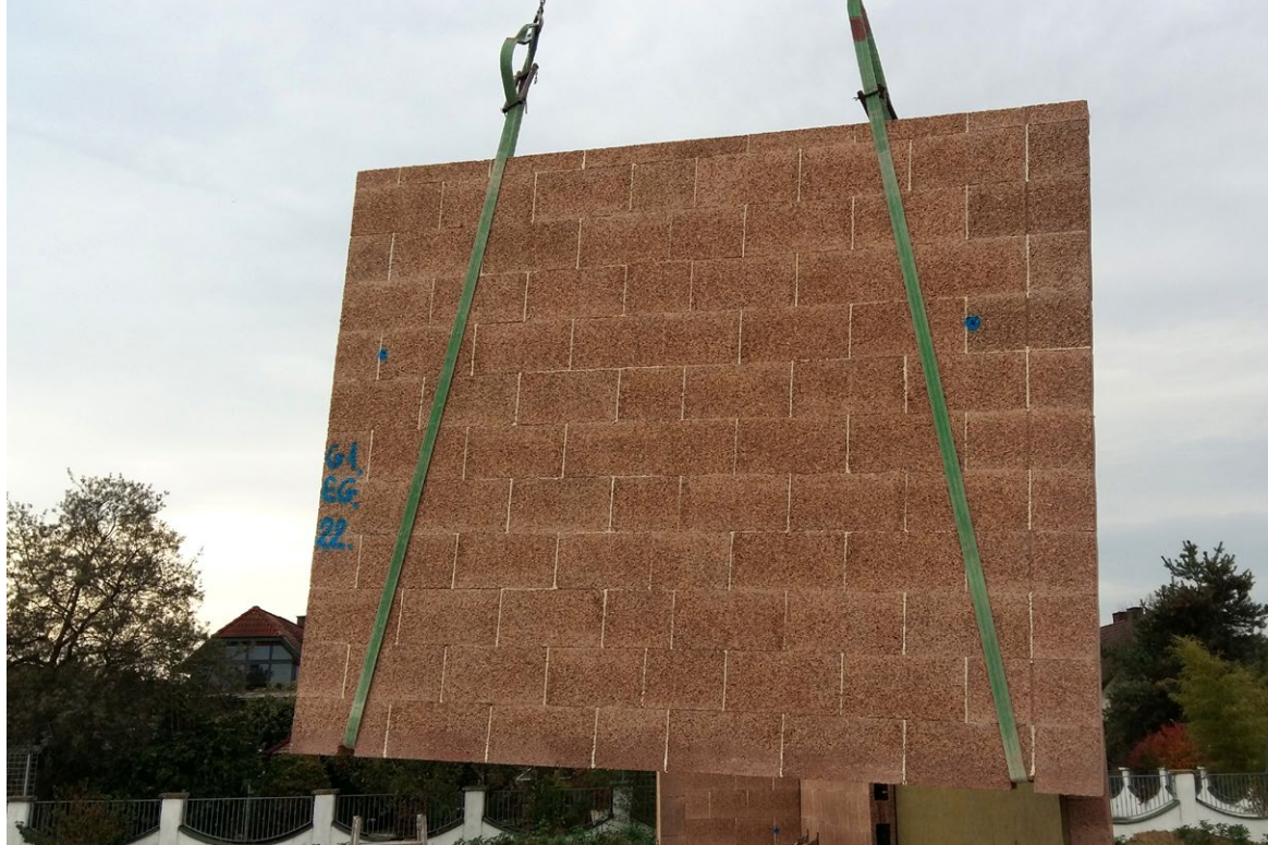
4.7. ábra Durisol kéregfal elem emelése hevederekkel
