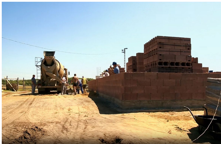
2.10. ábra Durisol fal szakaszos betonozása transzportbetonnal
