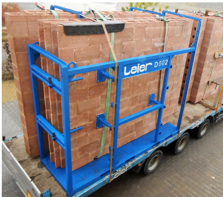
4.6. ábra Durisol kéregfal elemek szállítása kalodákban
