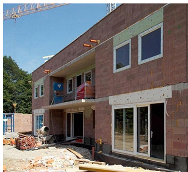
5.9. ábra Szerkezetépítés kéregfalakkal Wals- Siezenheimben
