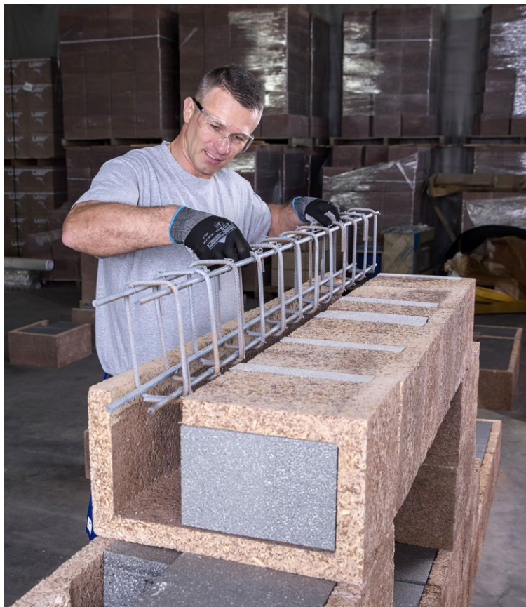
2.4. ábra Áthidaló kialakítása a DSs 45/12 L univerzális elemekkel
