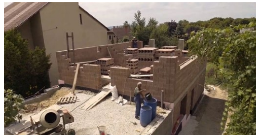
5.4. ábra Egy kétszintes magastetős családi ház szerkezetkész képei
