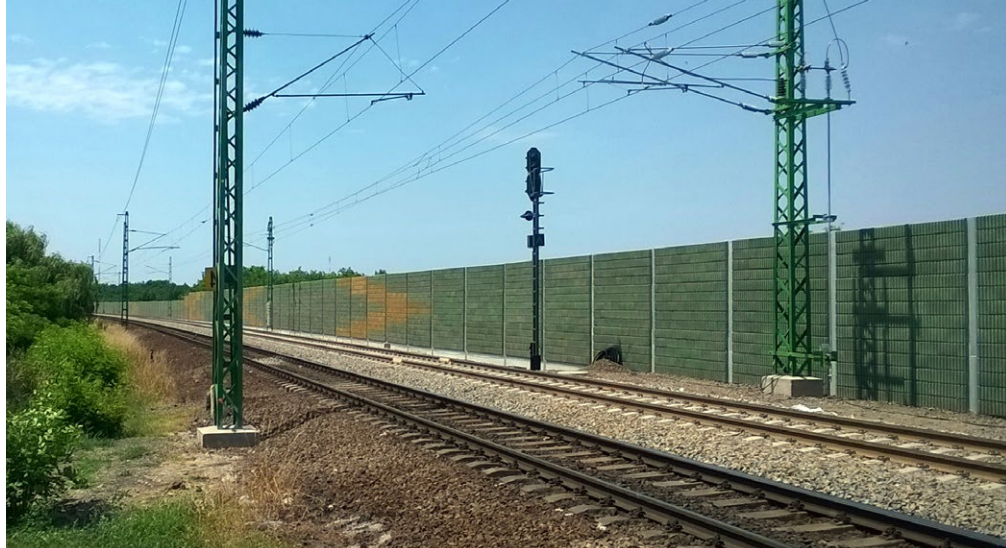
1.8. ábra Durisol zajárnyékoló fal alkalmazása vasút mellett
