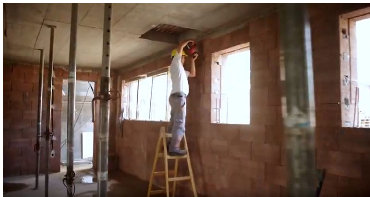
3.9. ábra Villanszerelés előkészítése, horonymarás Durisol falban
