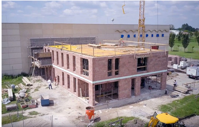
5.12. ábra A mórahalmi papírgyár fejépülete Durisol fal- szerkezetekkel
