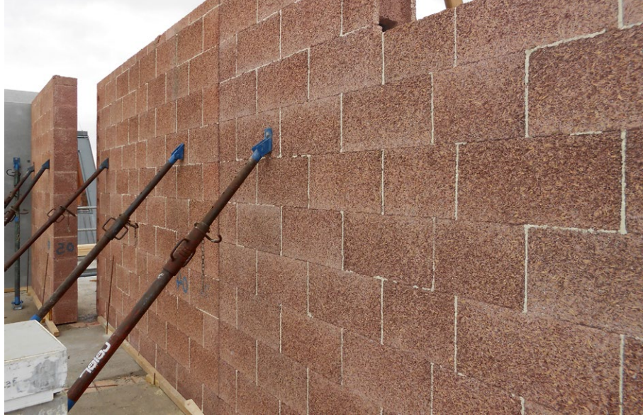
4.9. ábra Durisol kéregfalak megtámasztása ferde támaszokkal
