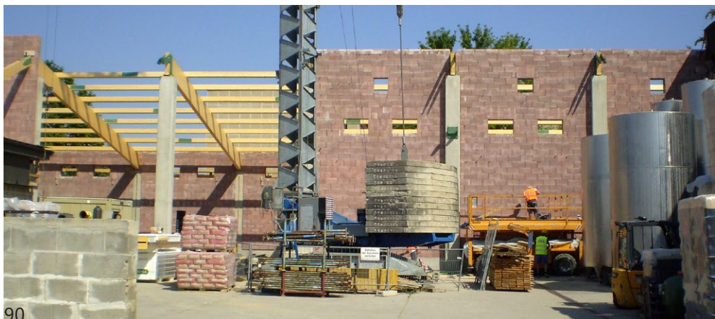
5.13. ábra Csarnoképület épül Rusztón vasbeton pillérekkel, rétegelt ragasztott fatartókkal és Durisol kitöltőfalakkal
