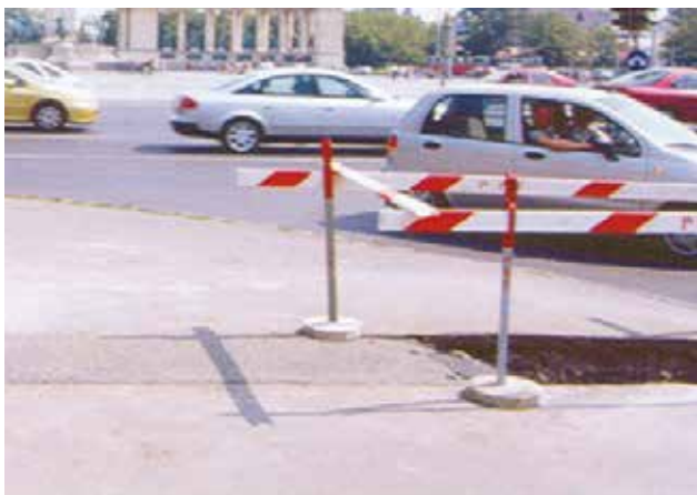
⬆ Felbontott aszfalt – a bontás során elszállítandó hulladék keletkezik
