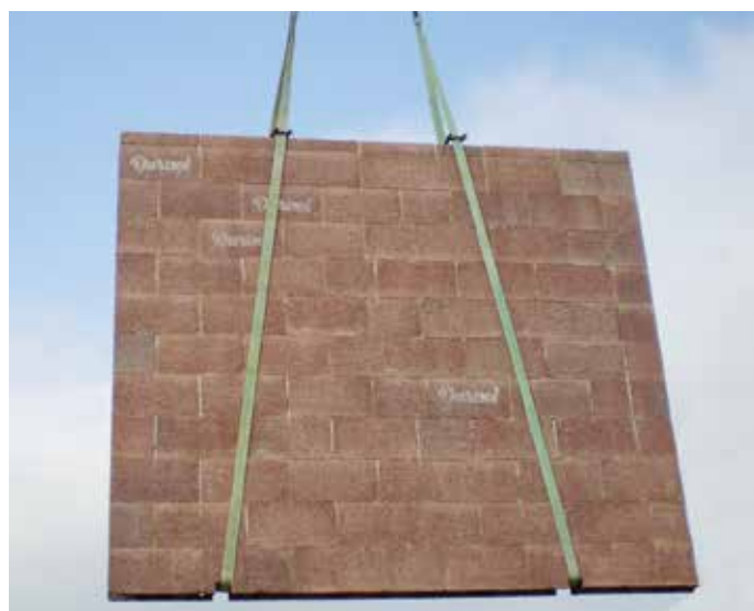
DURISOL kéregfalak maximális mérete 5,00 x 3,00 m
