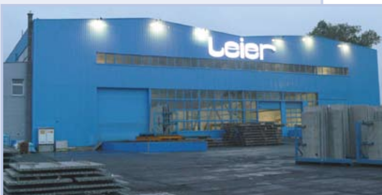
A malborki födém-, és szendvicspanelgyártó üzemünk új külső lakkozást és felíratozást kapott... • Unser Decken- und Hohlwandwerk in Malbork hat eine neue Fassade bekommen
