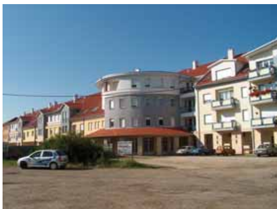
Kecskemét, társasházak (tégla, áthidaló, födém, tetőcserep).
