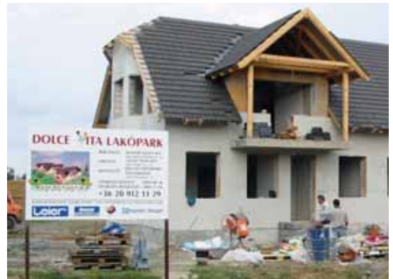
Ménfőcsanak – Lakópark építése Leier zsaluzó- és falazóanyagok, valamint beton tetőcserép felhasználásával.
