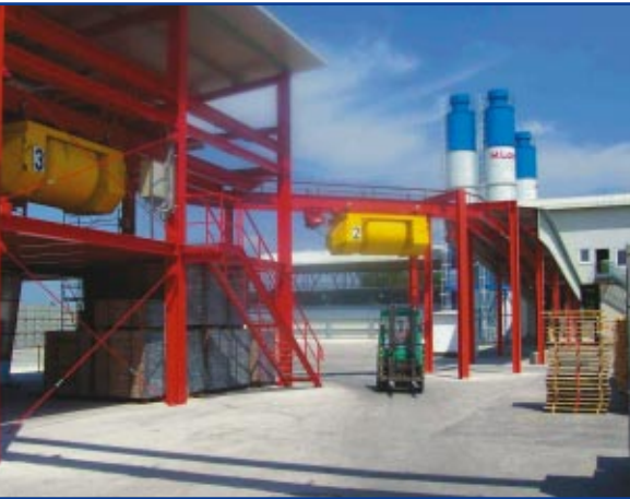
Betonhordó csillepályarendszer Beschickungsbahn für die OMAG- Anlage Taśma transportowa maszyny OMAG
