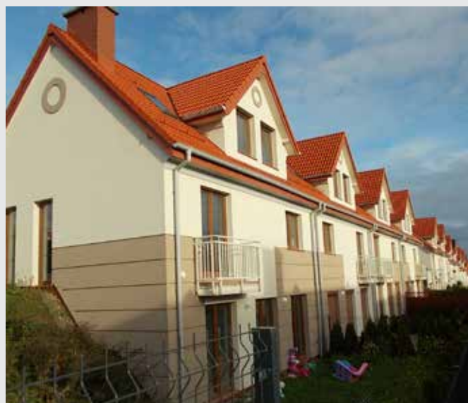
Neccon Gdańsk Tennisowa 2 – Mesterpanel, előregyártott lépcsők
