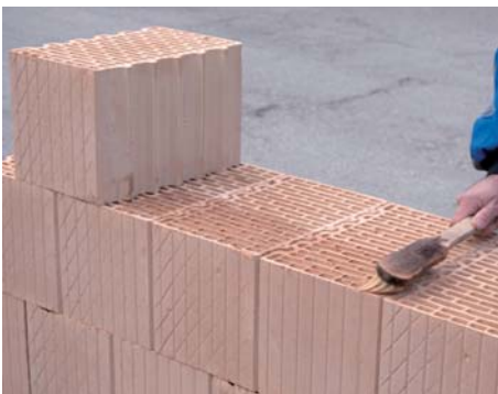
13. LeierPLAN falazóelem előnedvesítése ragasztás előtt
