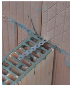
22. Válaszfalelemre hajtott bekötőszalag
