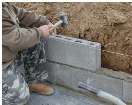
4. Válaszfalelem beállítása
