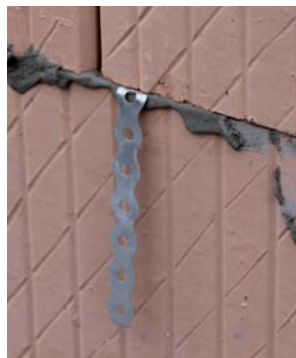
21. Lehajtott helyzetű bekötőszalag
