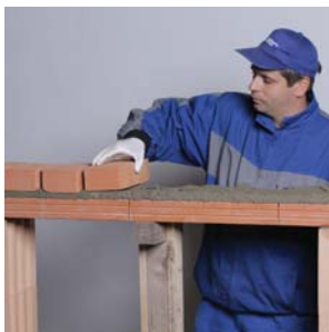
50. Nyomott öv falazása
