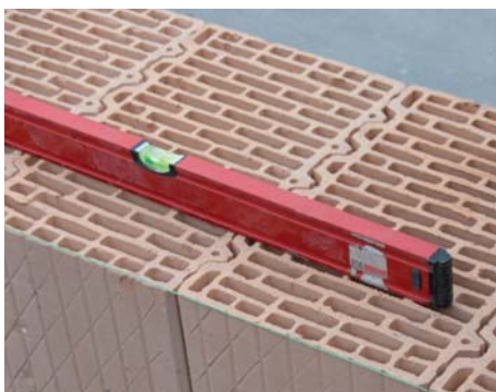
17. Faltest ellenőrzése vízmértékkel
