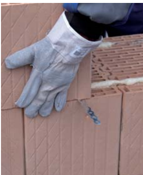
20. Falazóelem elhelyezése bekötőszalagos csatlakozásnál
