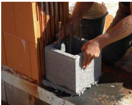
9. Első pillérzsaluzó elem elhelyezése
