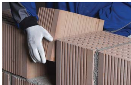
37. Vágott elem elhelyezése hanggátló falba (25/30 AKU)
