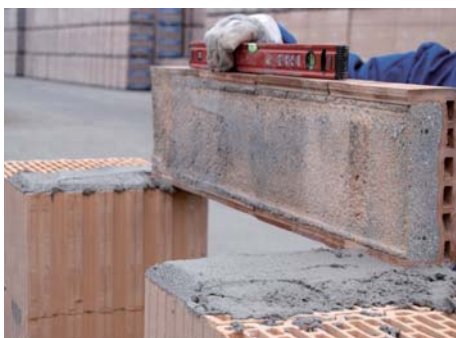
43. Felfekvés felület LeierPLAN falszerkezet esetén
