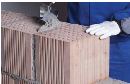
36. Hanggátló fal függőleges habarcshezag (25/30 AKU)
