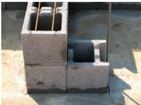
5. Falsarok kialakítása
