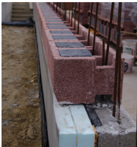
2. Leier falazóelemes lábazatra épített Durisol falszerkezet (összekötő vasalással)
