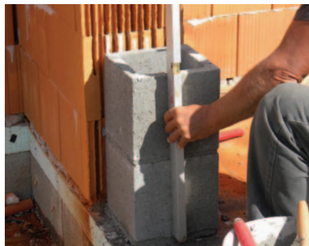
10. A függőleges ellenőrzése
