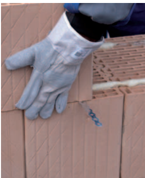
20. Falazóelem elhelyezése bekötőszalagos csatlakozásnál
