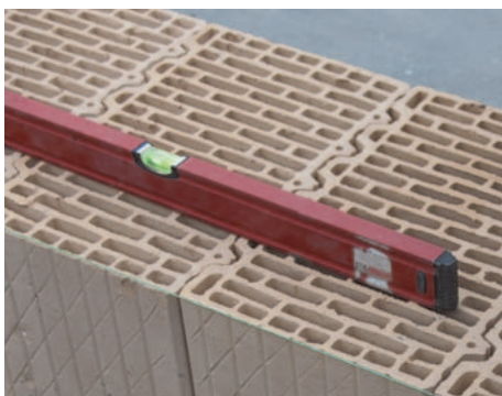
17. Faltest ellenőrzése vízmértékkel
