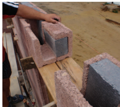
21. A nyílásáthidalás építése
