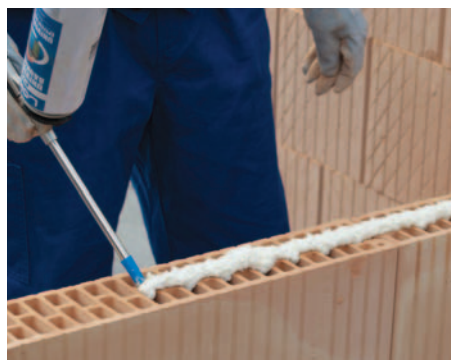
24. LeierFIX univerzális építési ragasztó felhordása a válaszfalelem középső bordájára
