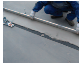
4. Kezdősor alatti habarcságy kialakítása nivelláló készlettel
