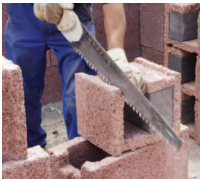
20. A nyílásáthidalásba építendő elem bordáinak kivágása
