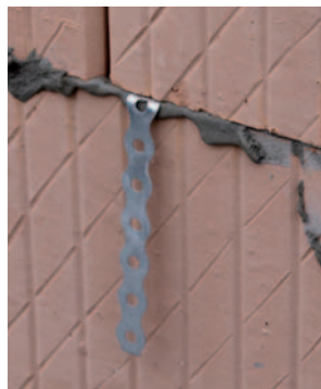
21. Lehajtott helyzetű bekötőszalag
