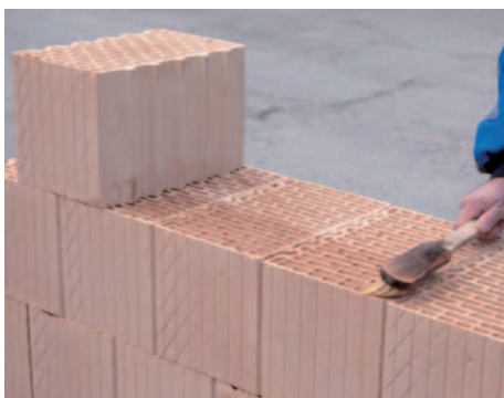
13. LeierPLAN falazóelem előnedvesítése ragasztás előtt
