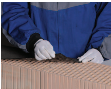
18. Falszerkezet lezárása bitumenes szigetelőlemezzel
