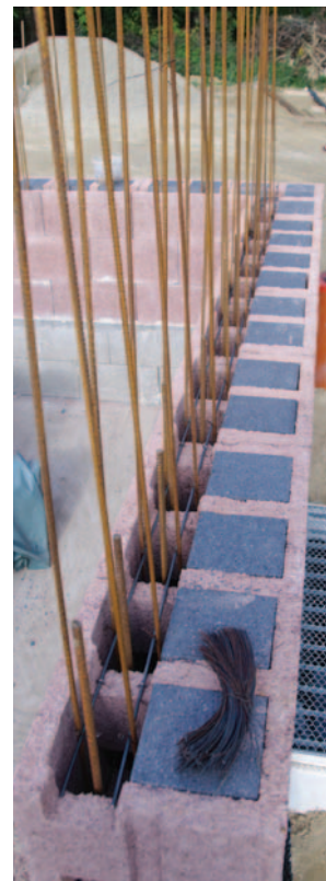
11. Durisol falszerkezet építése erősítő vasalással
