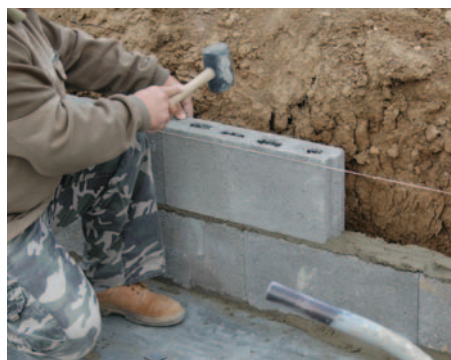
4. Válaszfalelem beállítása
