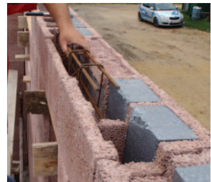
22. Vasalás behelyezése a nyílásáthidalásba
