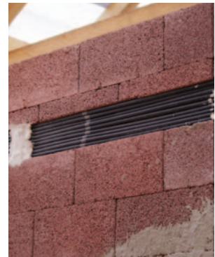
27. Mart hornyba süllyesztett vezeték
