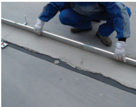
8. Kezdősor alatti habarcssáv kialakítása
