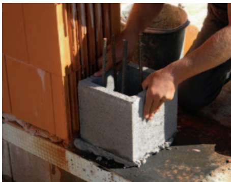
9. Első pillérzsaluzó elem elhelyezése
