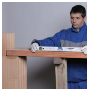
49. Vízszintes helyzet ellenőrzése
