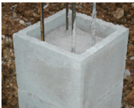
12. Kibetonozott pillérzsaluzó elem
