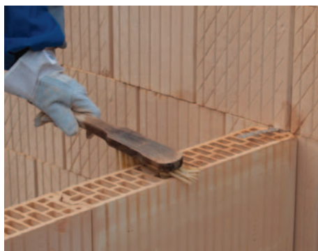
23. LeierPLAN válaszfalelem előnedvesítése
