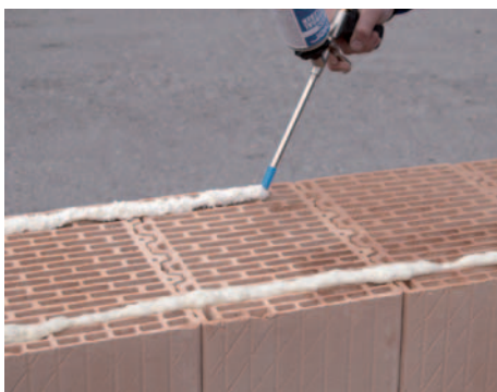
15. LeierFIX univerzális építési ragasztó felhordása a szélektől 5-6 cm távolságra
