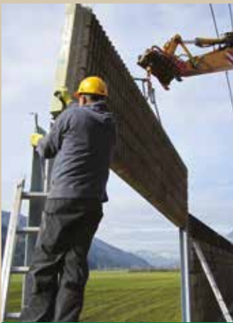
A Leier zajgátló falelemek beépítése
