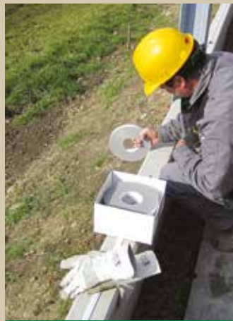
A tömítőszalagok elhelyezése
